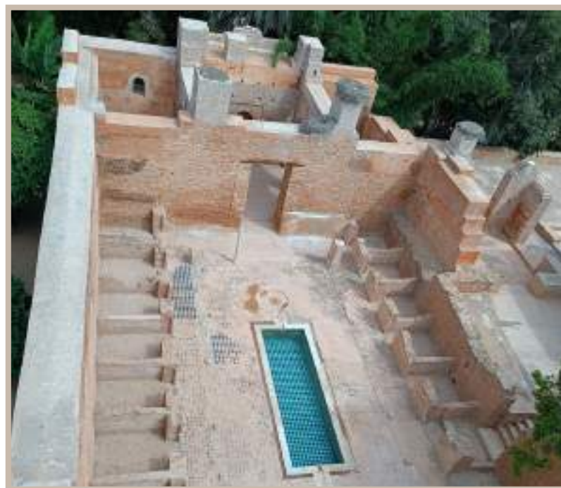
Figura 6: Vista aerea della Medersa Merinide restaurata.
