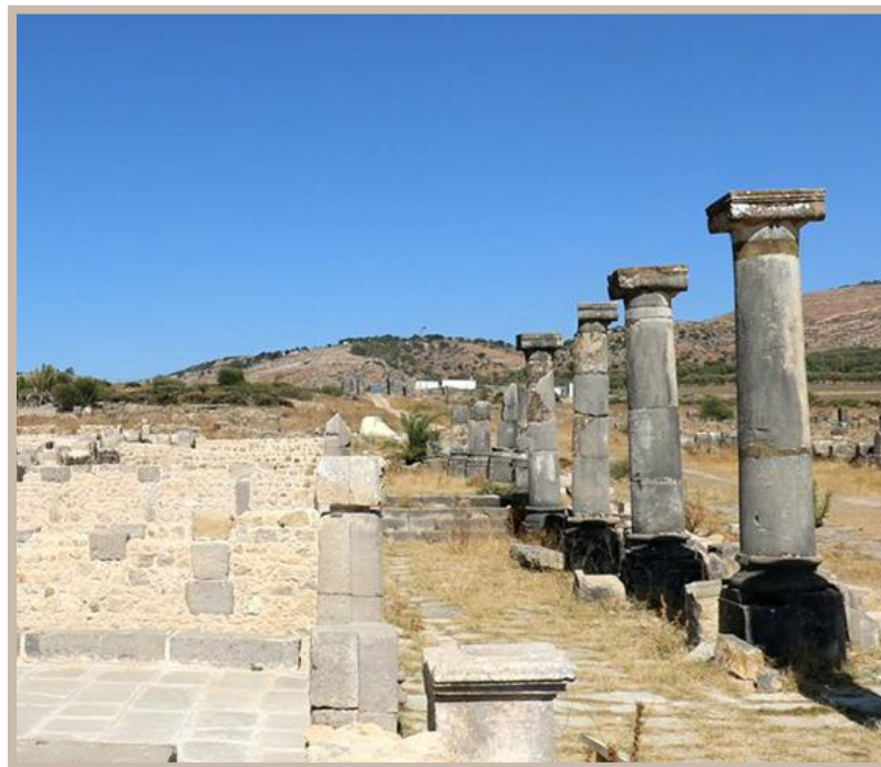
Figura 9: Vista di una parte del Palazzo di Gordiano dopo dell'intervento di restauro.
