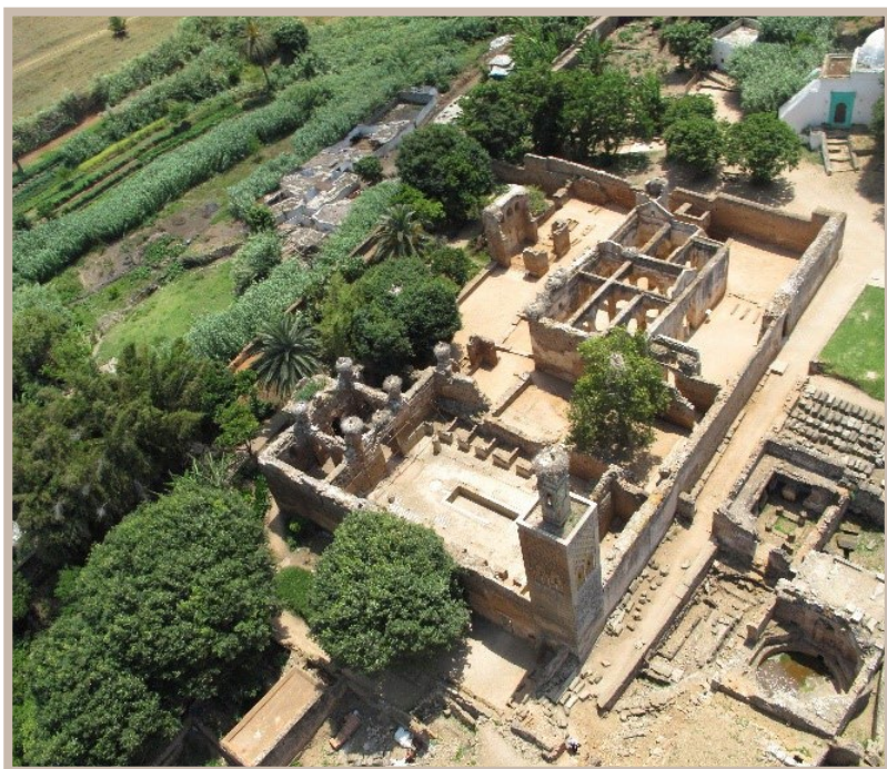
Figura 5: Vista aerea della Medersa Merinide prima dell'intervento di restauro 20 .
