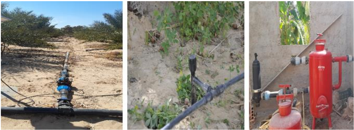
Figure 31 : Conduites du système barboteur
