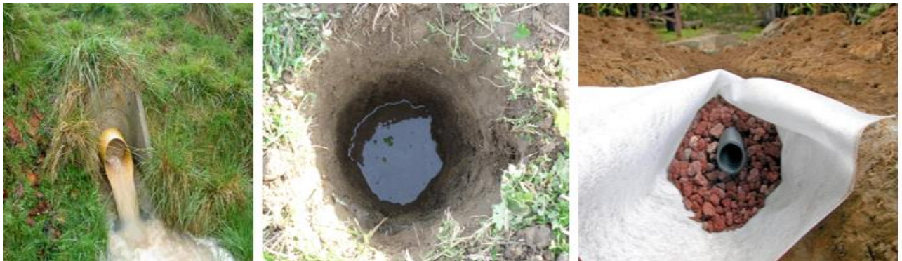
Figure 23 : Exemples de drainage souterrain
