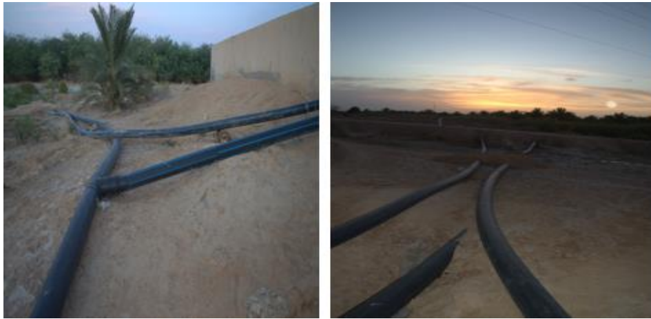
Figure 29 : les conduites en polyéthylène dans les parcelles
