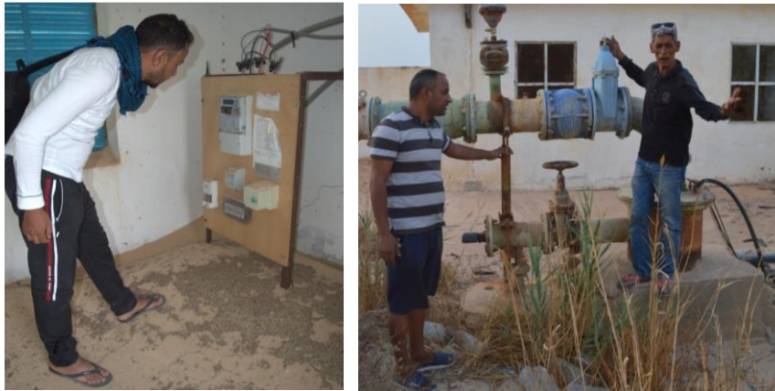
Figure 3 : Visite sur terrain par les deux enquêteurs
