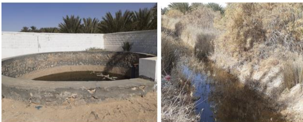
Figure 18 : Etat de réseau de drainage de Hezoua 2
