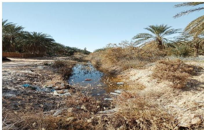
Figure 26 : Drainage de surface à Hezoua2
