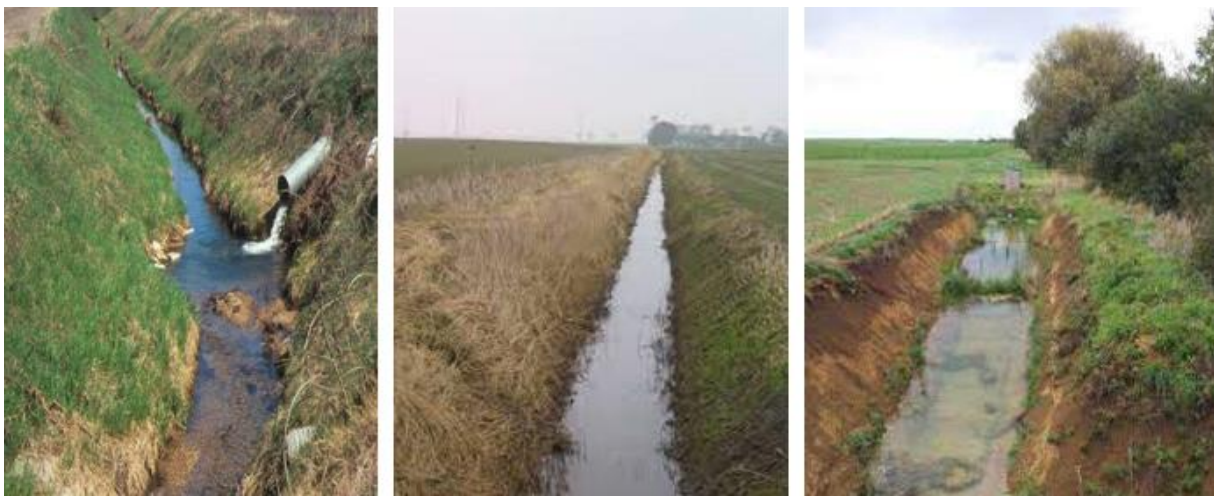
Figure 25 : Exemples de drainage de surface
